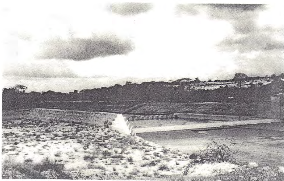
P.3. Baricho Weir
